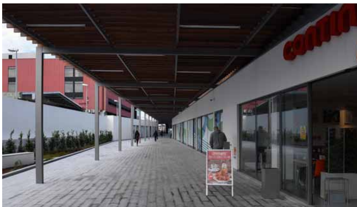
Diariamente deverão transitar 10 mil pessoas entre a estação e a Zona Empresarial do Porto
